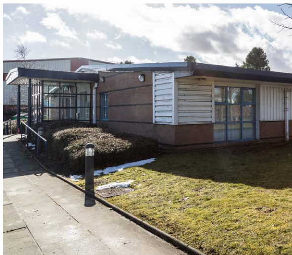
Instalaciones de Apex en Loanhead
